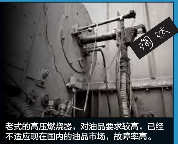
老式的高压燃烧器，对油品要求较高，已经不适应现在国内的油品市场，故障率高。
