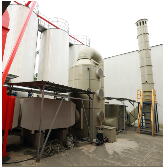
沥青烟气三级处理设备 (水喷淋+静电除尘+UV光解)
